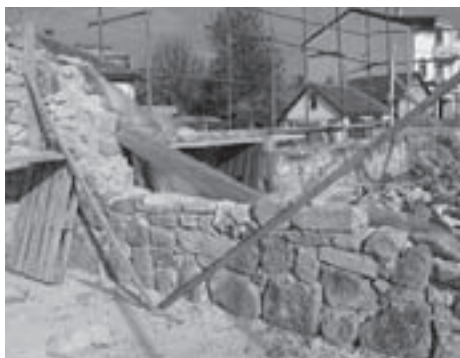
Slika 17: Gazanferija džamija u Banjaluci u toku rekonstrukcije 2007. godine – u zidu su vidljivi fragmenti doprozornika, munare i nišana (foto: Amra Hadžimuhamedović, 2007.)
